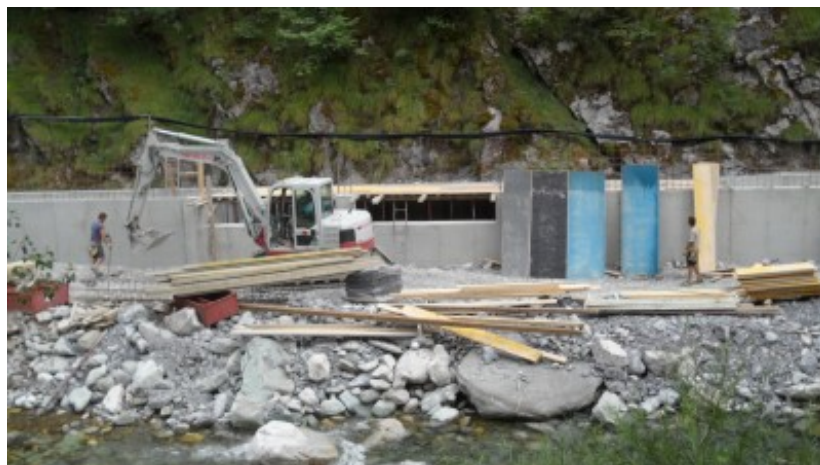
Ponte di Nava, lavori in corso sul Tanaro per la centrale idroelettrica
